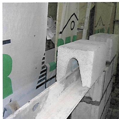
Blocs linteau posés à l'envers pour dissimuler les cornières
