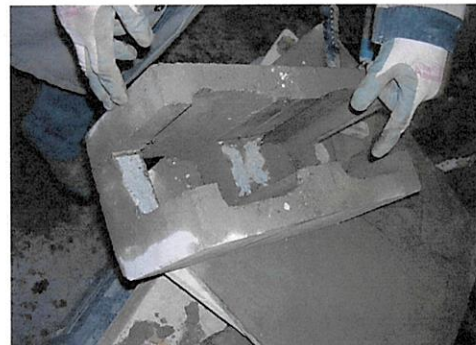
Bloc scié pour remplacer un bloc linteau
