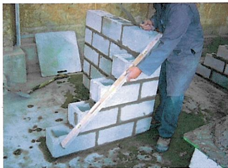
Figure 3.8 Vérification de la planéité du coin (diagonale)
