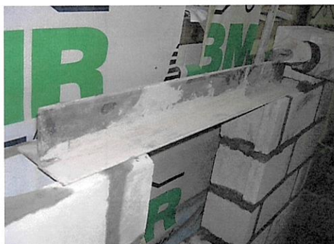
Cornières dos à dos (éléments de support)
