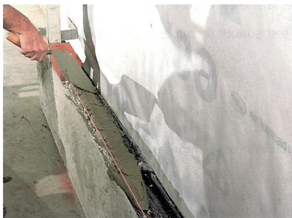
Figure 3.3 Étendage du mortier pour les briques
