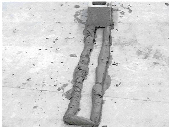
Figure 3.2 Étendage du mortier pour les blocs
