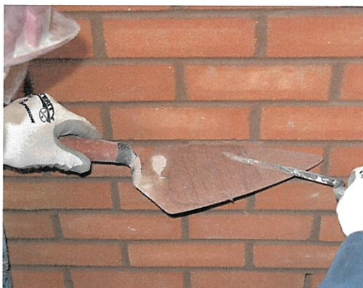
Bourrage des joints à l'aide de la truelle « langue de chat »
