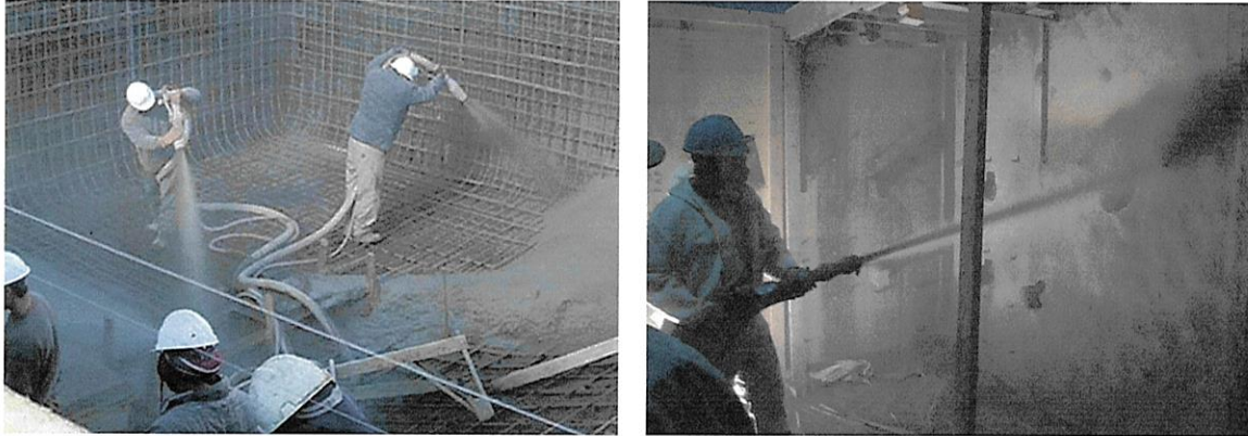
Figure 5.6 Projection de béton réfractaire
