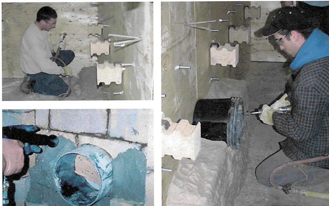
Figure 5.5 Installation du plastique réfractaire par méthode pneumatique et à la main
