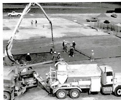
B) Bétonnière mobile
