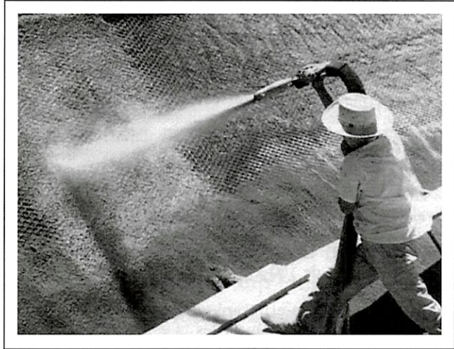
Figure 49 Béton projeté (CPCA)
