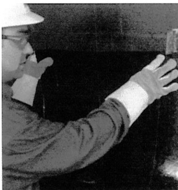
Figure 18 Pose de membranes thermofusibles (Soprema)
